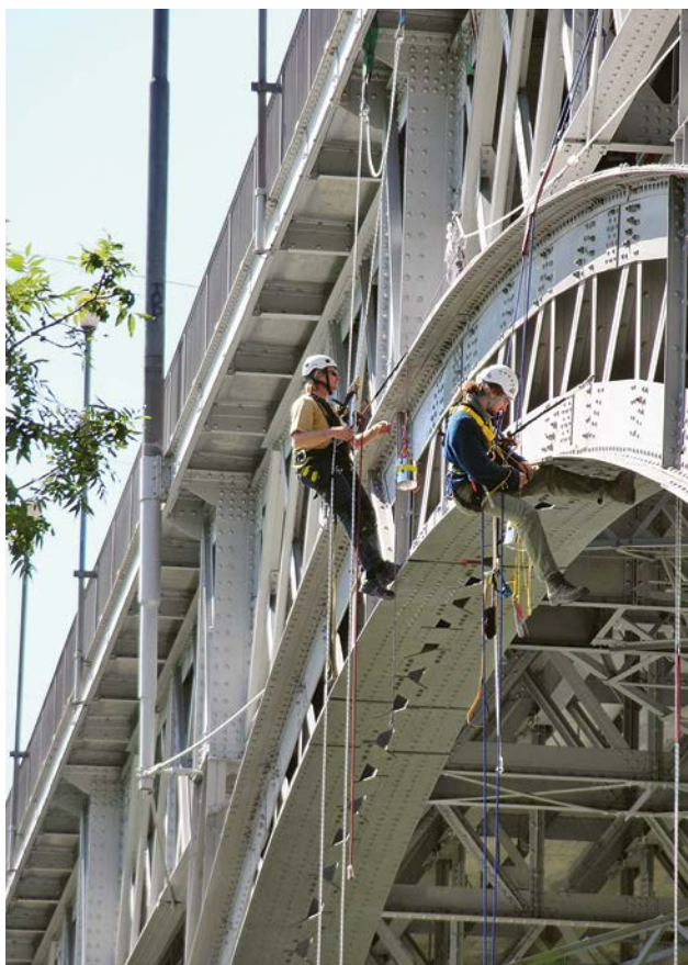
Fig. 2 Lavori in sospensione a corde portanti
